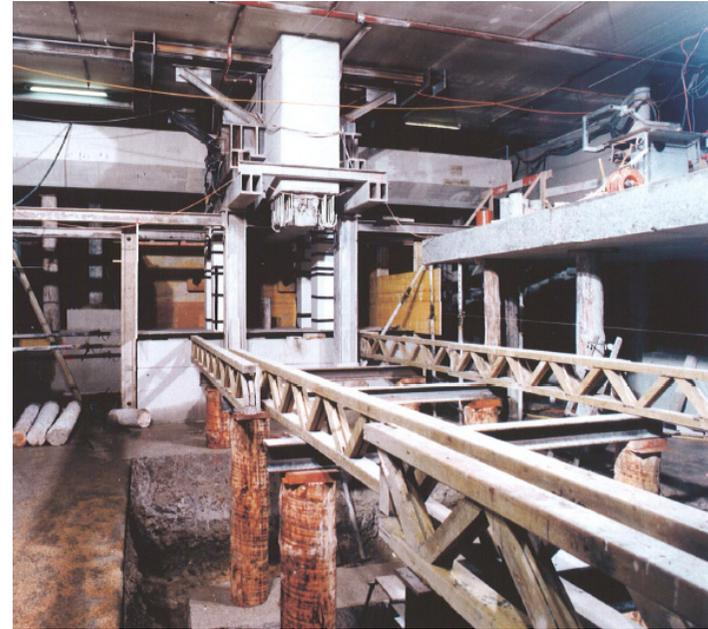
Illustration: reprise en sous-œuvre du bâtiment SSF, tunnel du Zimmerberg, Weststrasse, Zurich
